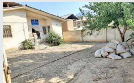
محوطه خانه بهداشت «وامنان» قبل از بازسازی ▲
